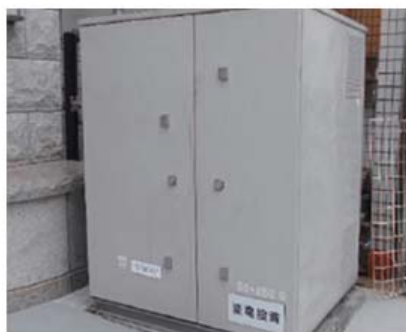
集合住宅用変圧器
